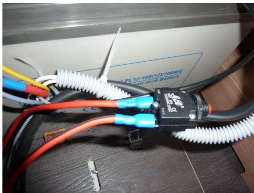
Kabel mit Kabelbindern fixieren (Beispiel)
