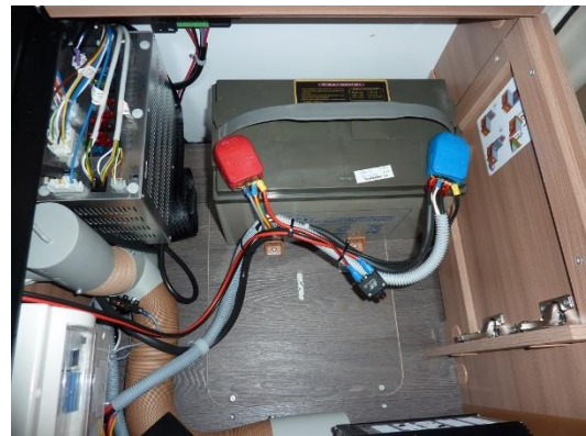
Kabel fertig verlegt
